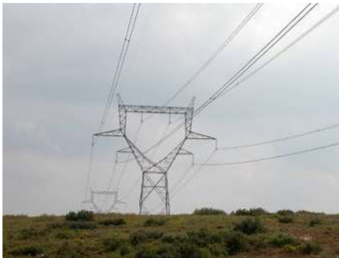
La ligne haute tension entre Sagriès et Sanilhac
