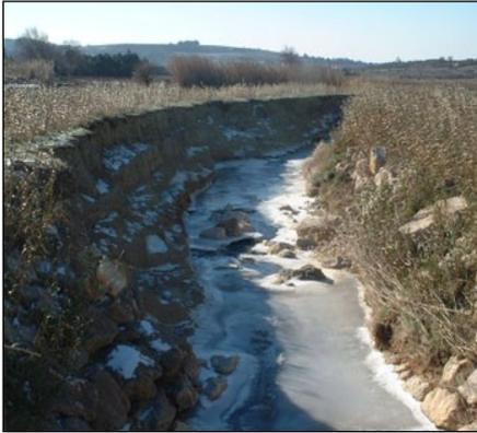
*Erosion du talus interne de la digue rive gauche à l'aval du pont des Avons*
